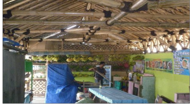
Kios yang telah diperbaiki
