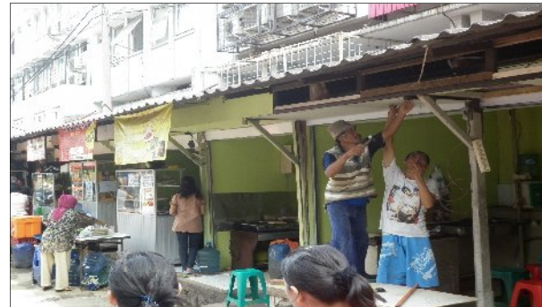
Kios yang sedang dalam proses renovasi (tempat cuci piring sudah di dalam kios)
